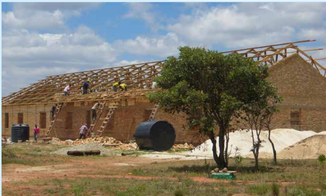
Il dormitorio della scuola di Mibikimitali in costruzione, 2015
