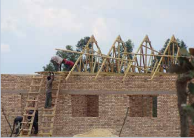
Il dormitorio della scuola di Mibikimitali in costruzione
