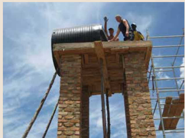
Installazione tank per l'acqua al dispensario di Ibwanzi
